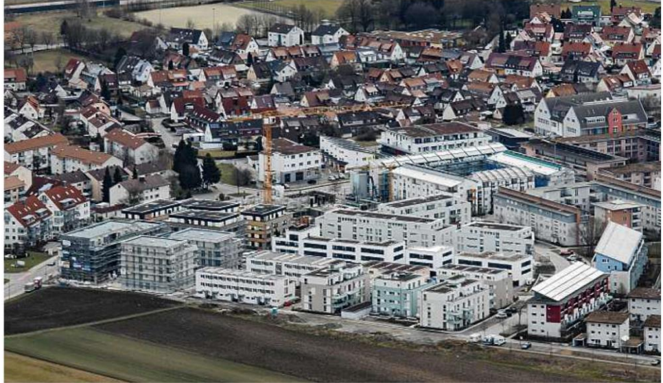
Noch sind nicht alle Bauarbeiten beendet, aber in Wiggenshausen-Süd sind 250 neue Wohnungen entstanden, davon die Hälfte für Haushalte mit Wohnberechtigungsschein. Wer knapp über den Einkommensgrenzen liegt, kam nicht zum Zug. Das soll sich ändern. BILD: KATY CUKO
