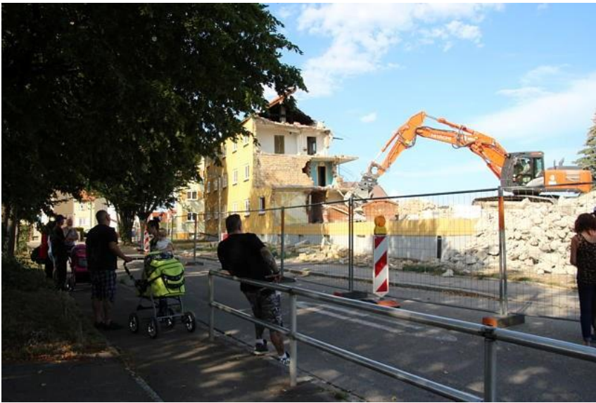
Anwohner haben sich in der Eintrachtstraße versammelt und verfolgen, wie das Haus Nummer 18 nach und nach abgerissen wird. Bild: Mona Lippisch
