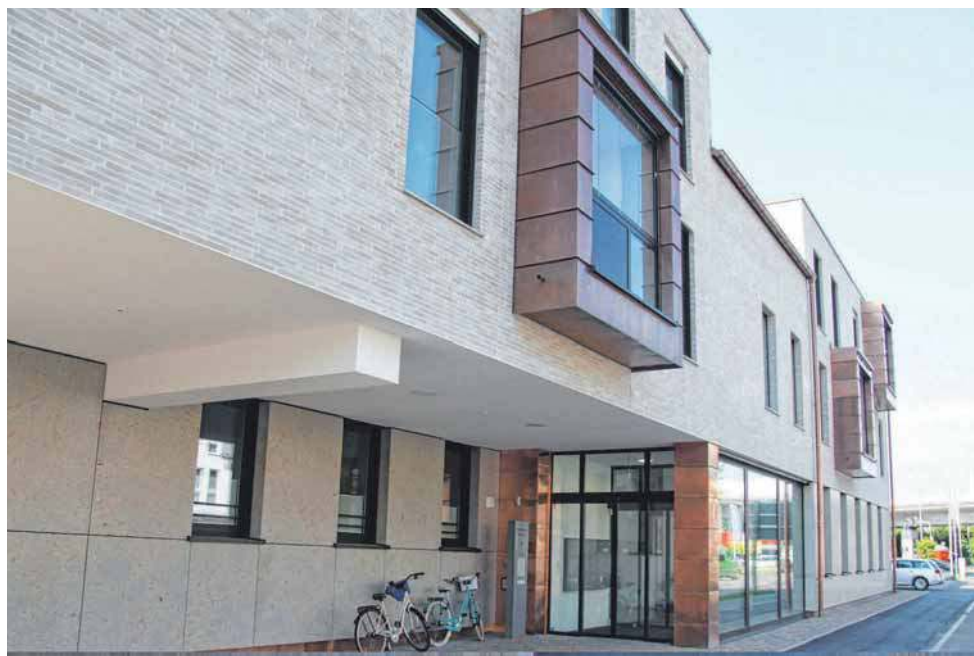
Der Neubau der SWG an der Ravensburger Str. 30 ist ein Blickfang und wird höchsten Ansprüchen gerecht.
