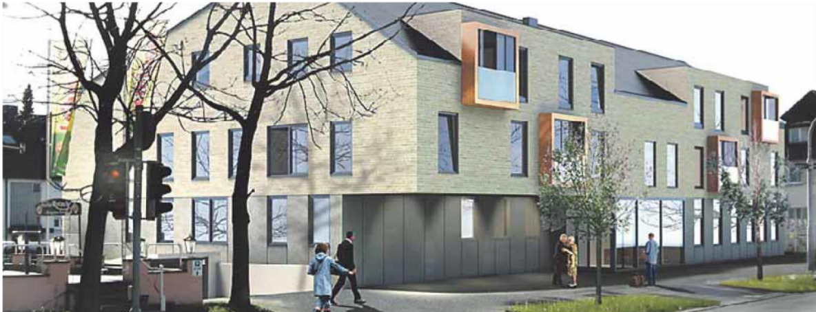
Im Herbst 2017 soll der „Vitalis“-Neubau für Senioren in der Ravensburger Straße 30 bezugsfertig sein.
